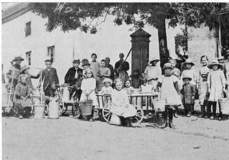
Alte Pumpe Wassernot 1921
